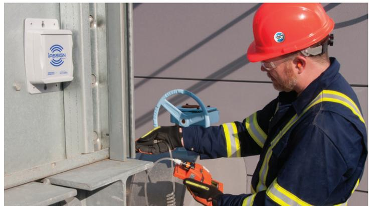
**iAssign Beacons** – Automatisches Zuweisen einer Lokation bei den Mehrgaswarngeräten der Ventis® Pro5 durch Annäherung. Dies hilft den Verantwortlichen etwaige Belastungen durch Gase Personen und Orten zuzuordnen.
